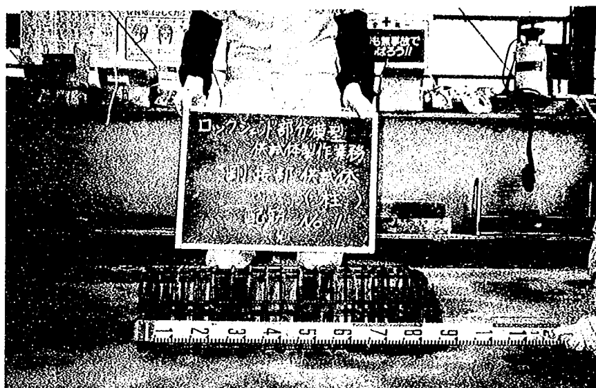
写真－3. 1 2 剛接部供試体（柱）鉄筋組立時
