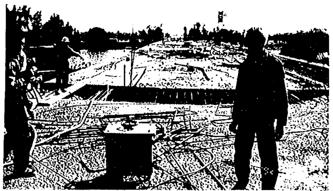
写真-39 架設中の桁
