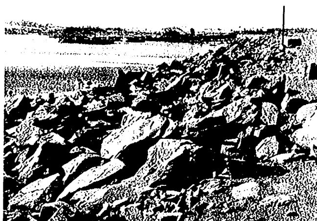
写真-72 巨石が積み上げられたロック部分
