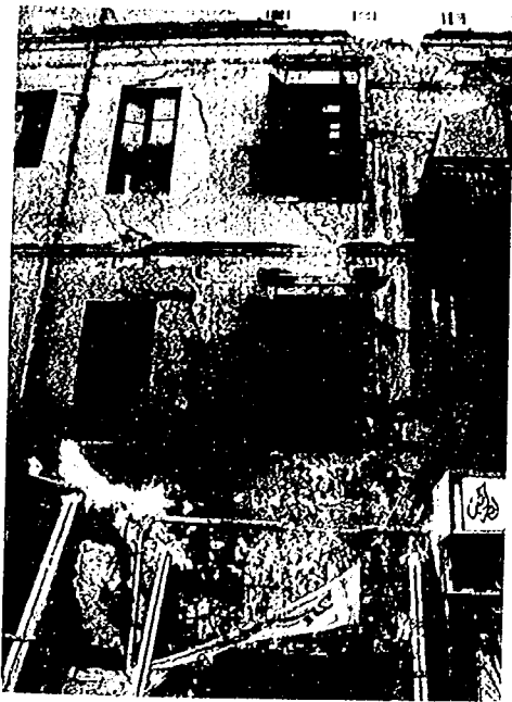
写真-18 石造建物(3階建て、クラックが多数はいつているが、かなりのものは地震前から入っていたと考えられる、カイロ市内)
