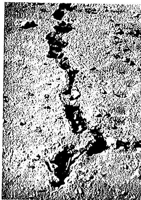
写真-2 クラックの詳細(単純に左右に引っ張られたようで、横ずれらしきものは見られない。幅約10cm)
