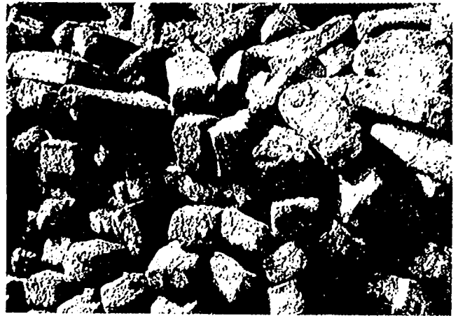
写真-13 日干しれんが(繊維質が混じっているので比較的軽い)
