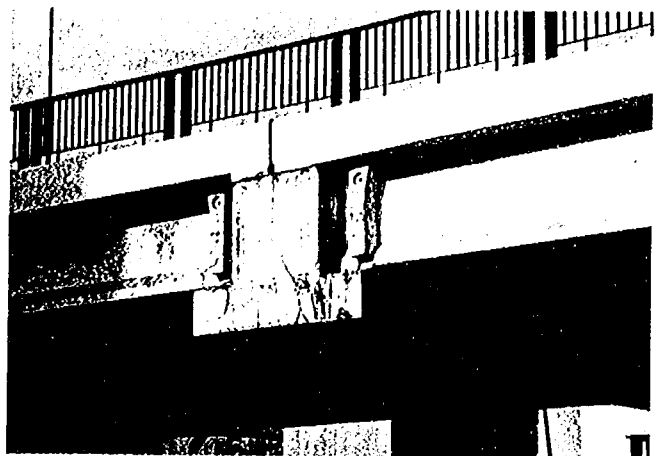
写真-48 掛け違い部
