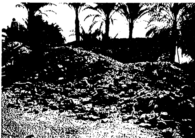
写真-16 日干しれんがの代わりに石を用いた建物の倒壊(倒壊すると、非常に危険な建物である)
