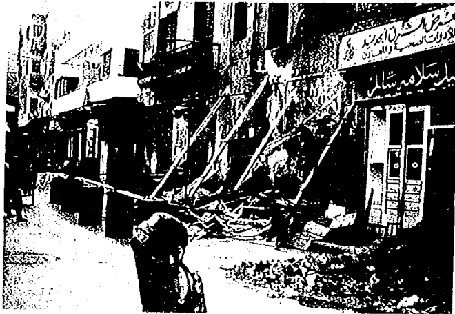
写真-19 石造建物(地震により傾斜したため、倒壊防止につかえ棒で応急的に支持している)
