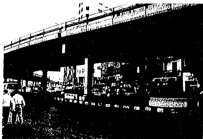
写真-46 カイロ市内の高架橋(鋼製橋脚、固定橋脚部では、斜め部材により橋脚を補剛している)
