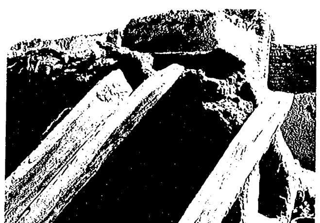
写真-15 壁と天井を構成する梁の固定部(この部分の梁は、椰子の木を輪切りにしたものである)
