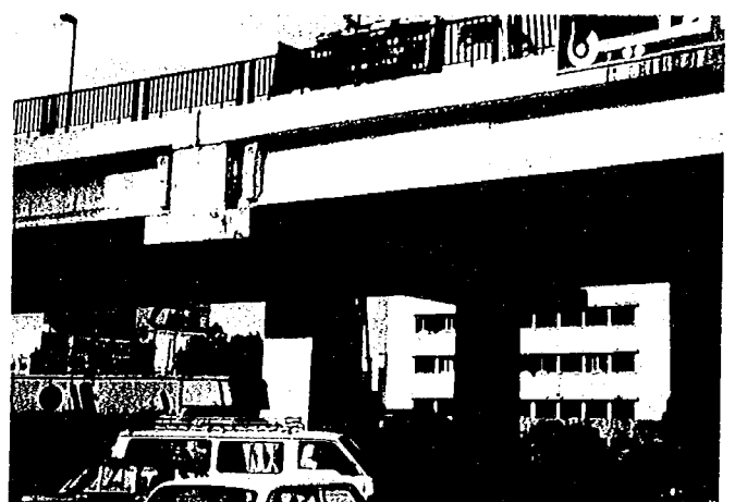
写真-47 カイロ市内の高架橋
