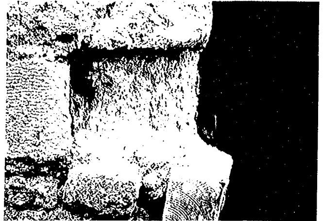
写真-21 風化した内部の石(表面のカバー(しっくい)のなかは、ぼろぼろに風化している、少し、粘土も含む柔らかい砂岩)
