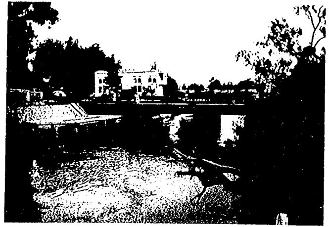
写真-55 回転橋(ナイルデルタ、船舶の航行用に回転できるようにになっている。このような橋が多数ある)
