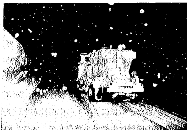
写真-5-7-5 凍結防止剤散布作業
