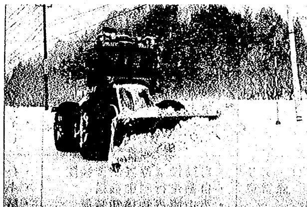
写真-5-7-8 除雪ドーザによる拡幅作業
