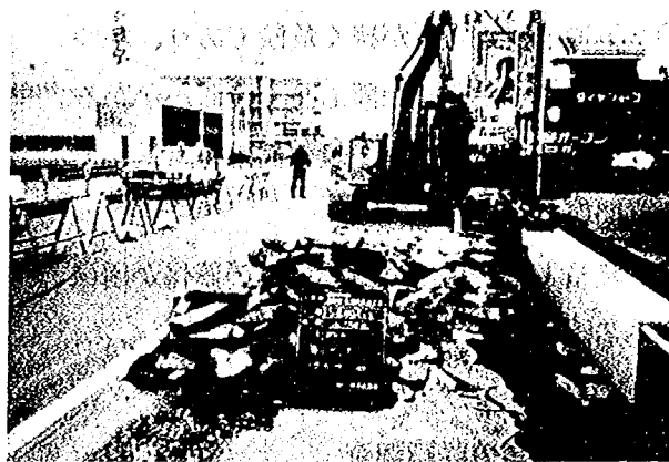
写真-4-4-4-2 舗装版切り壊し
