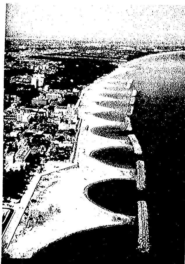
写真3-1-18 皆生海岸（離岸堤設置後）
