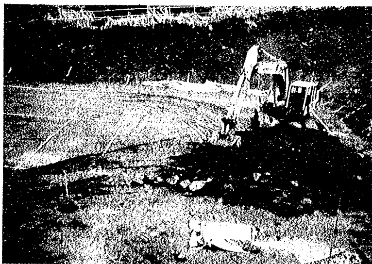
写真-3.1 バックホーによる敷均し
