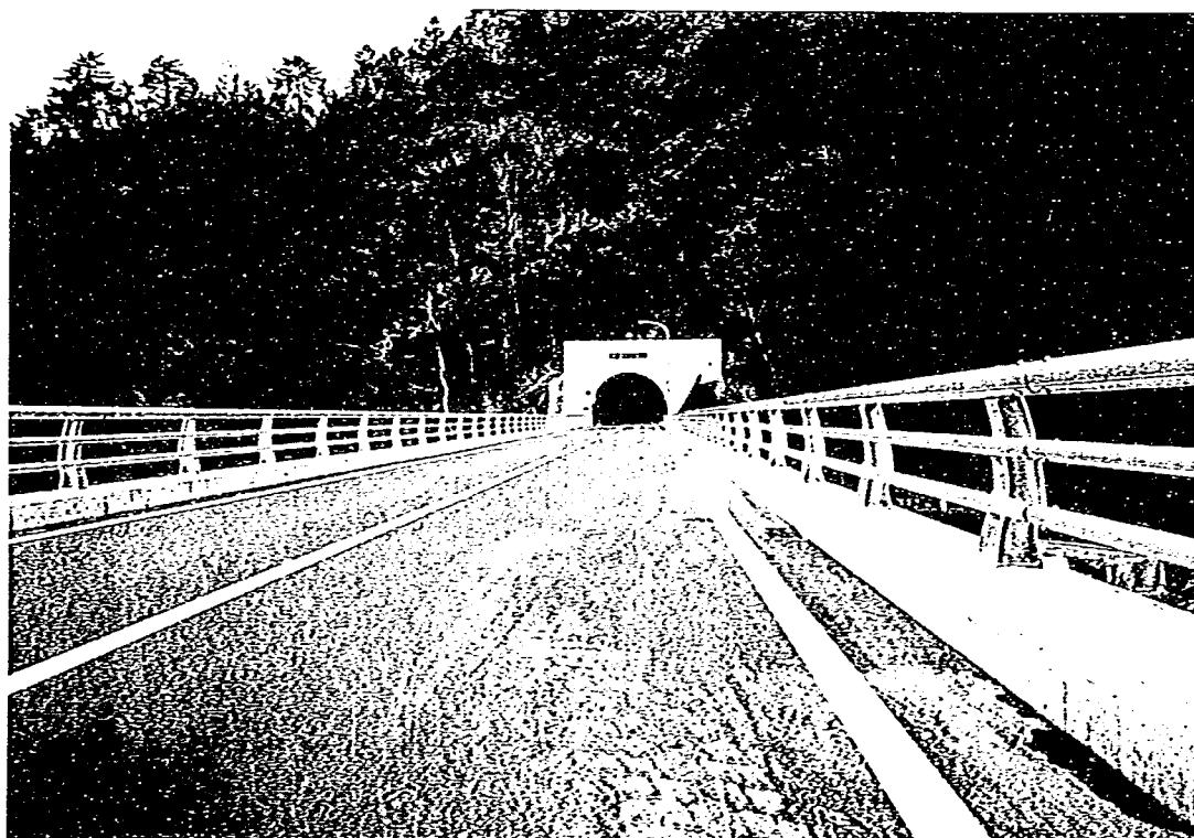
写真－5 橋梁用防護柵の施工例 (静岡県栗代橋、平成2年施工)
