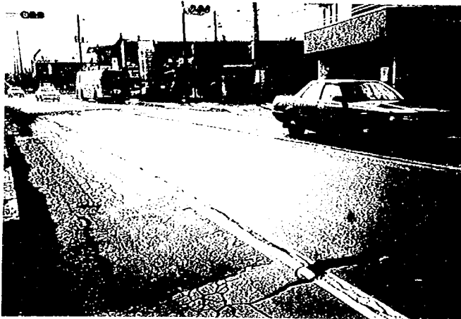
写真－4.48 東浜町地区の舗装面が移動した状況 (手前に移動により生じたアスファルト舗装の沈下溝が見える。現在は、盛り上がり部分が除去されている)
