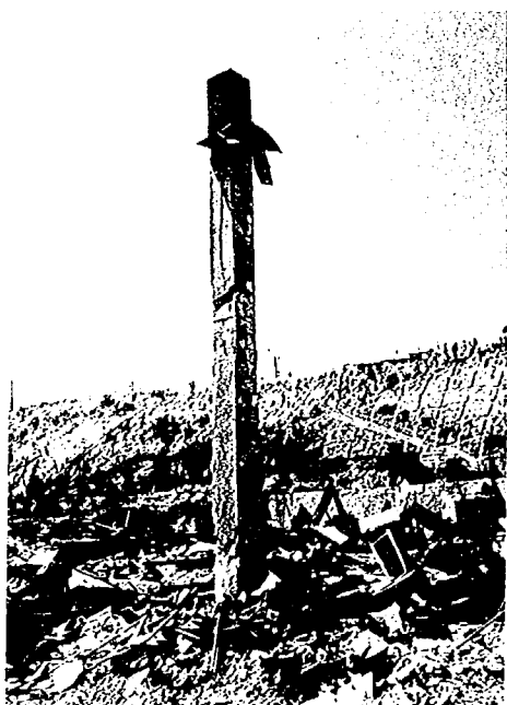
写真-6.28 青苗地区の火災状況(唯一残されたコンクリートブロック製の集合煙突)
