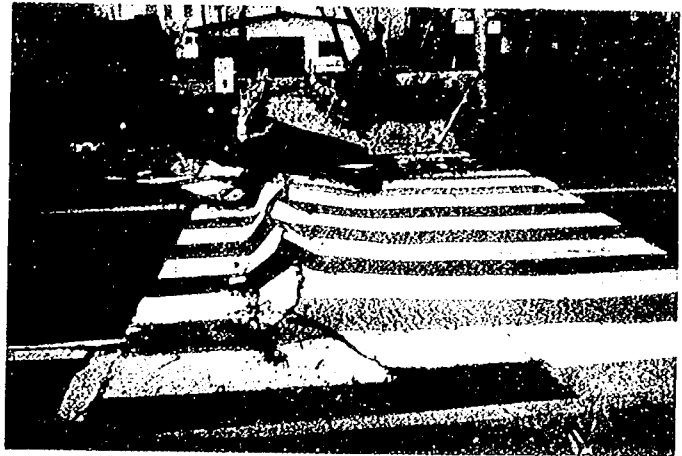
写真－4.47 東浜町地区のアスファルト舗装の盛り上がり (路盤の移動により衝突部で盛り上がりが生じた、北海道開発局函館開発建設部による)
