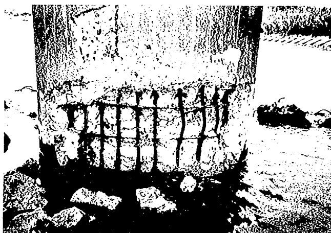
写真－４．３９ 新知内橋のP 3 橋脚の主鉄筋の座屈及びはら み出し(北海道道路課市町村道室提供)
