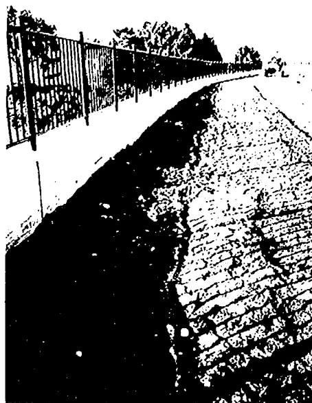
写真-4.74 国道228号の擁壁の傾斜と道路のクラック、沈下
