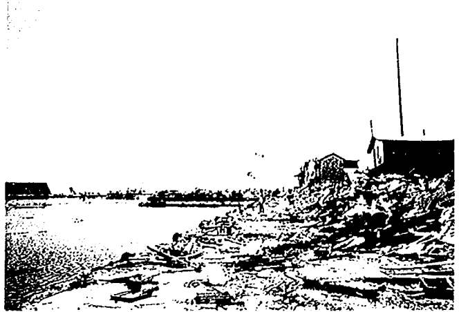
写真－6.3 青苗港岸壁付近の家屋の被害 (津波により破壊された家屋の残骸)
