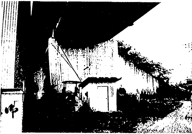
写真-2.1 上鳥崎橋(国道5号)における強震観測施設
