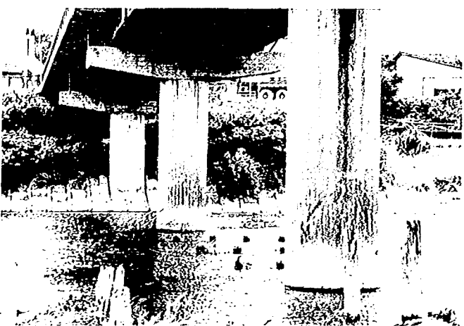
写真-4.17 基栄橋P2、P3橋脚の損傷
