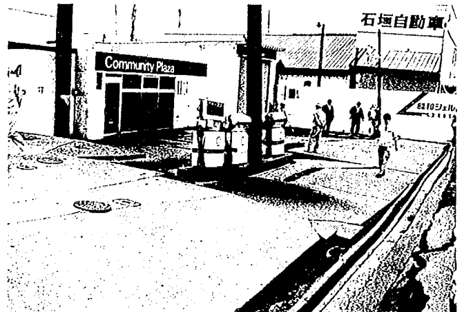
写真－４．８３ 国道５号沿いガソリンスタンドの舗装の沈下
