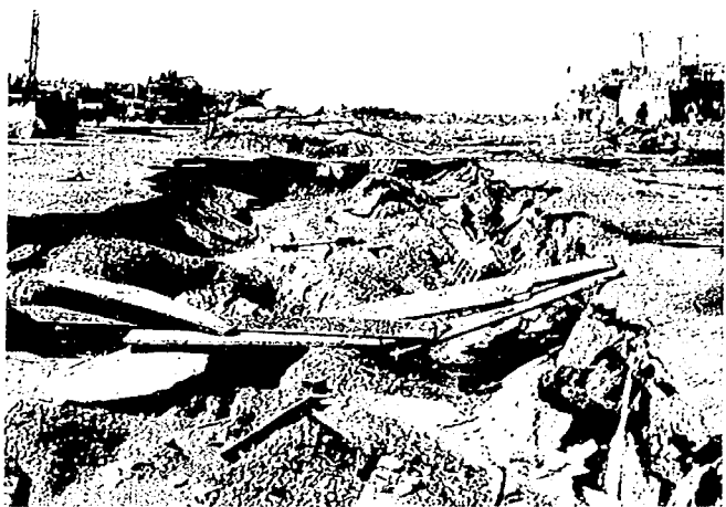
写真－7.3 函館港西埠頭北海道振興㈱第6岸壁 (エプロンの陥没)
