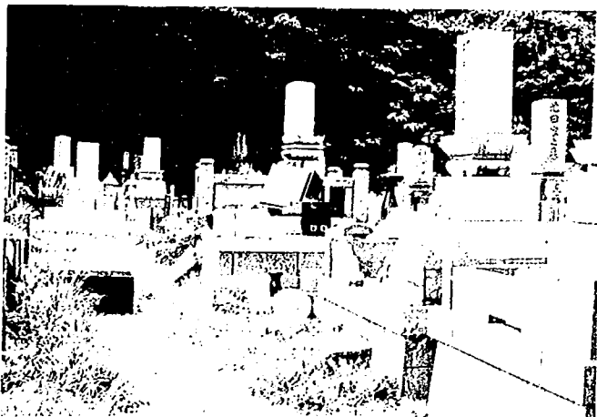
写真-2.5 江差町真宗大谷派東本願寺江差別院における墓石の転倒状況(総墓石数41基中3基が転倒)
