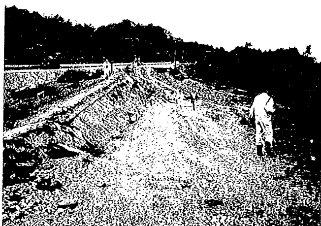
写真－4.42 国道5号長万部町知来地区の道路盛土の崩壊 (盛土部分に落下した車両を除去するために 整地した後、迂回並行して道路盛土を新た に復旧工事中)
