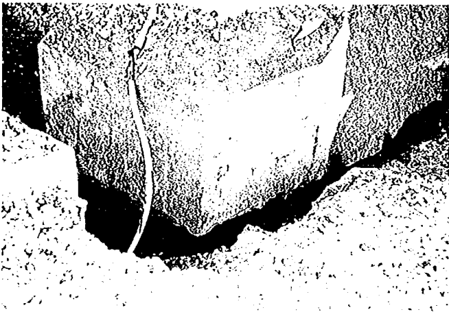
写真-8.3 建物のフーチング
