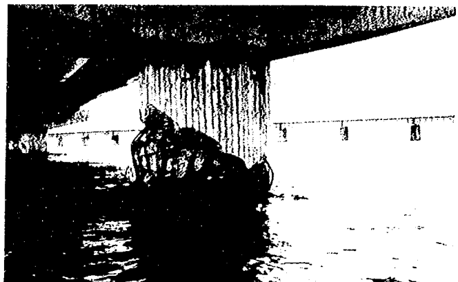
写真-2 静内橋P3橋脚の損傷（1982年浦河沖地震）
