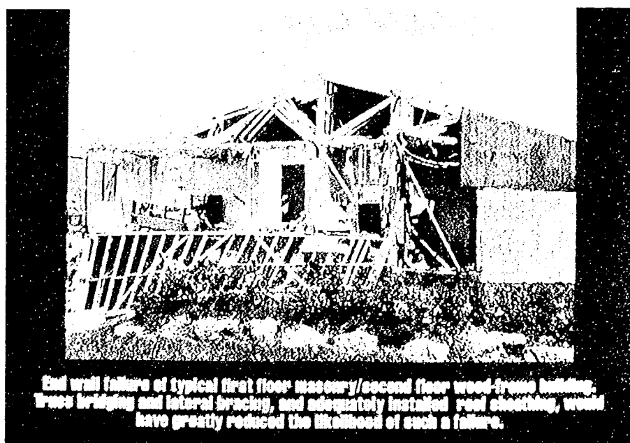
写真－6 外壁の倒壊
