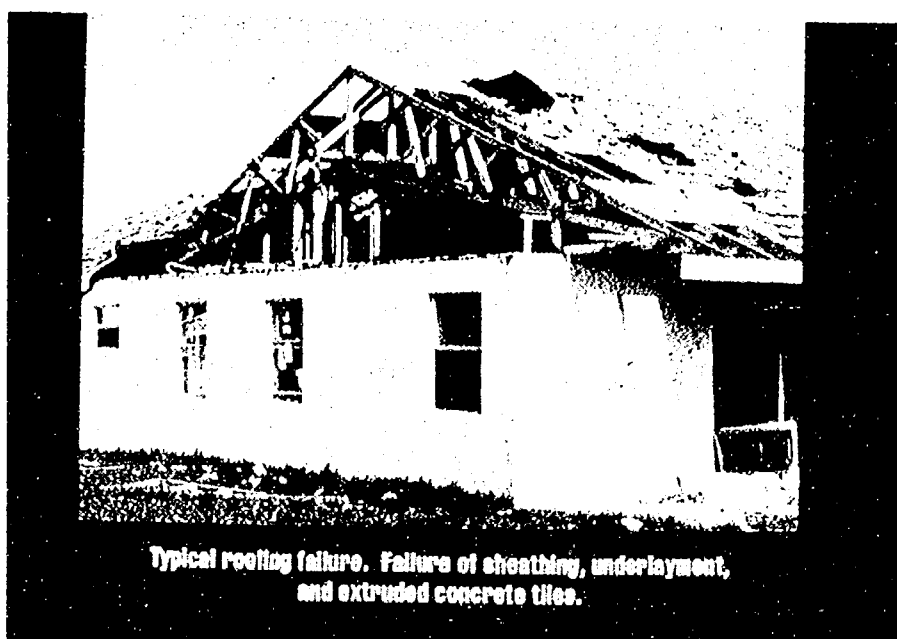
写真－9 典型的な屋根の損傷事例
