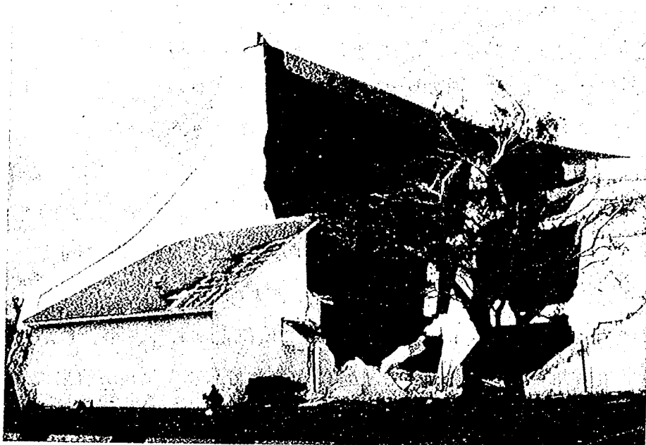
写真－４ ハリケーンアンドリューによる建築物の被害
