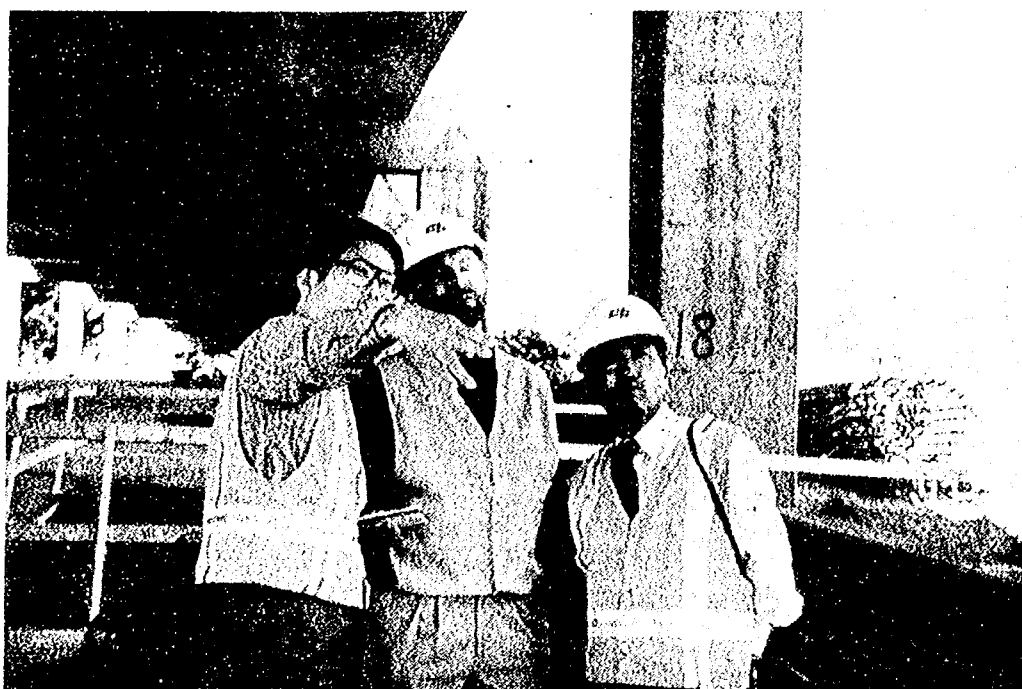
写真－7 耐震補強を行っている被災高架橋
