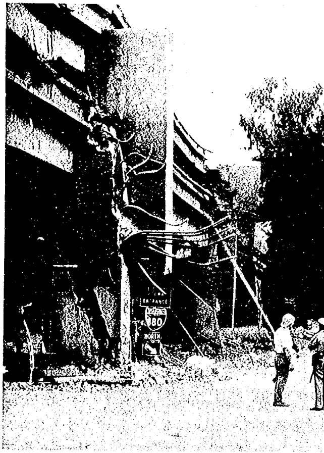
写真－４ ロマ・ブリエータ地震による高架橋の被害
