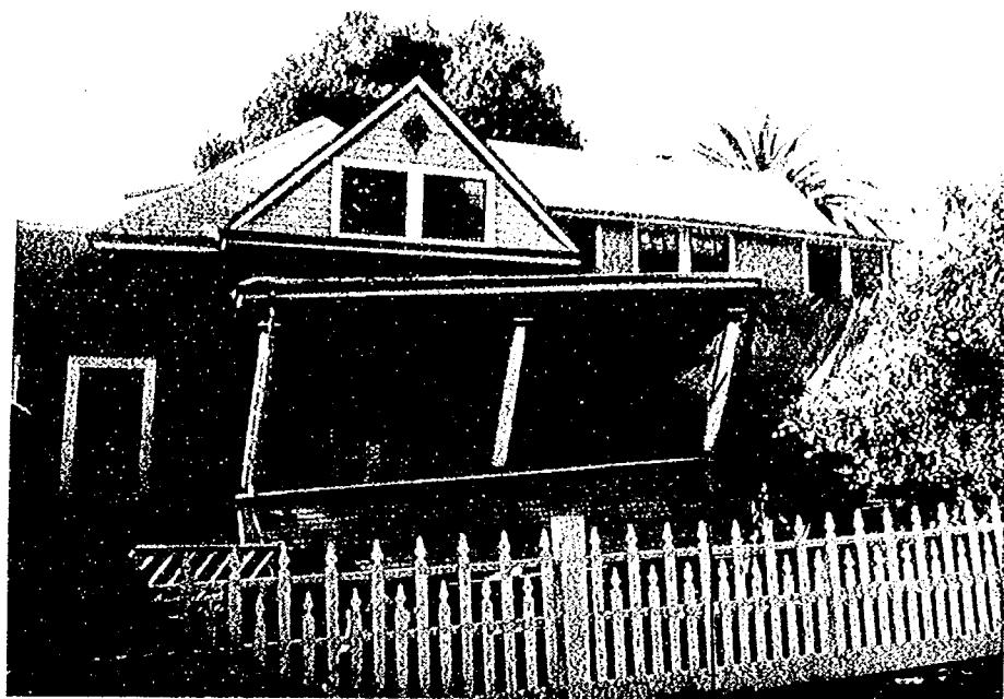
写真-2 ロマ・プリエータ地震による建物の被害(木造住宅)
