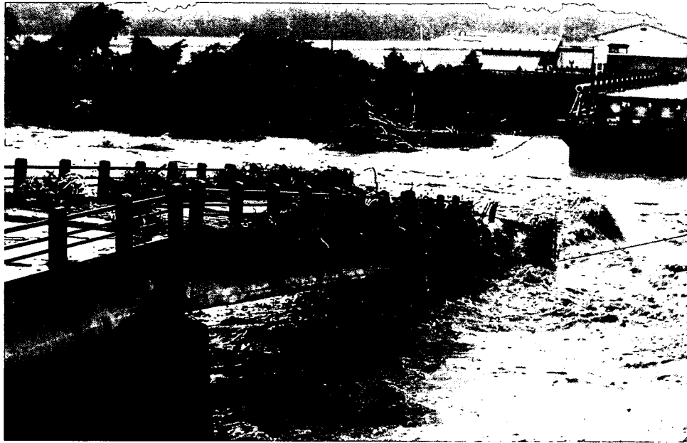
写真－５．１ 流木による橋梁の被災（岩手県，黒沢川川原田橋）
