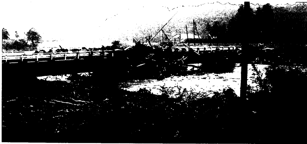
写真－５．２ 流木による橋梁の被災（岩手県黒沢川稲沢橋）
