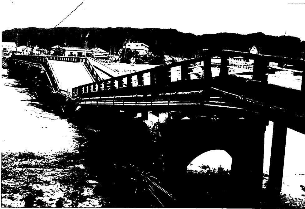
写真－１．２ 橋脚周りの局所洗掘に伴う被災事例（鹿児島県，日当山橋）
