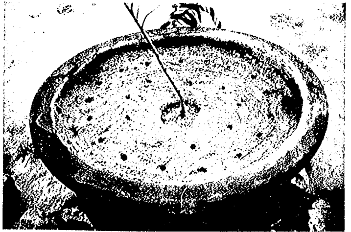
写真-5・26 モルタルの設置状況
