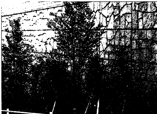
写真-2・2 擁壁前面の植栽
