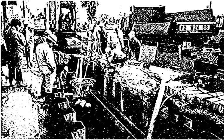
写真4.4 No65のマンホール 開削状況
