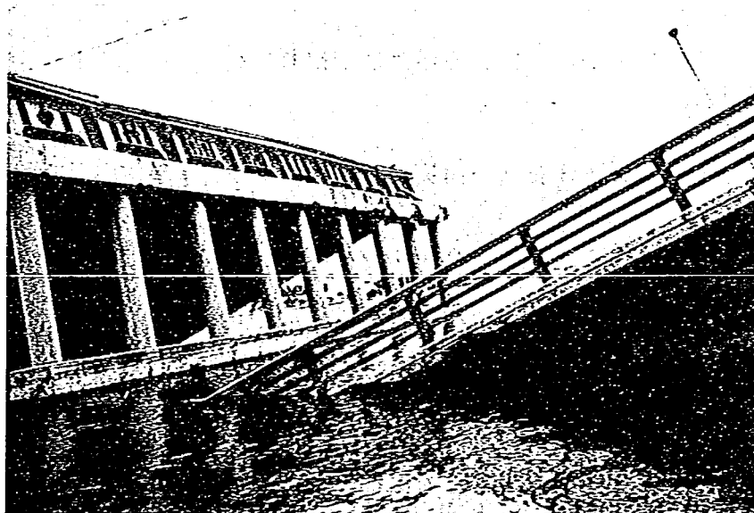
写真-2.1.4 昭和大橋のパイルベント橋脚
