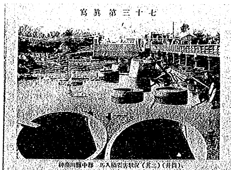
写真-2.4.4 大正12年関東地震による馬入橋の井筒の浮き上がり
