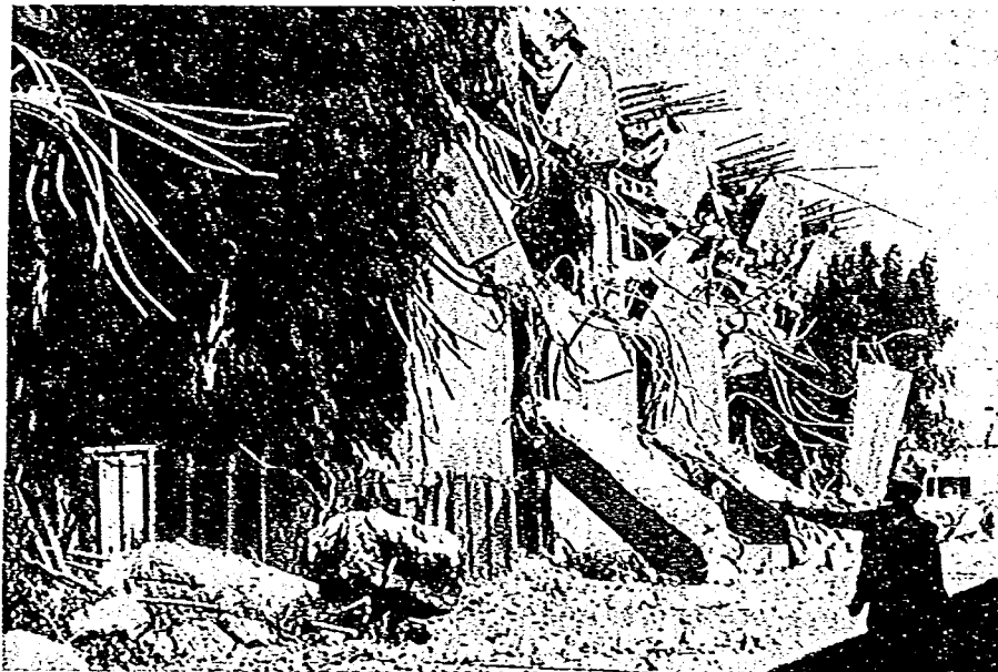
写真-2.4.3 1989年米国ロマプリエータ地震によるサイプレス高架橋の崩壊
