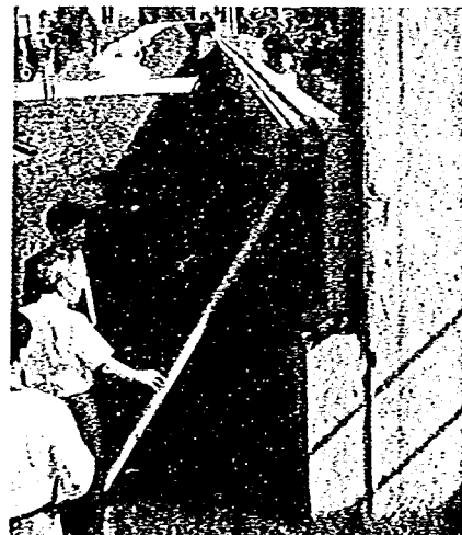
写真-6 対策により被災を免れた例(2) アイオワ州ベテンドルフにある折りたたみ式の洪水防護壁はコンクリート壁(1.2mと1.1m)とアルミ・パネル(1.1m)からなる景観に配慮したものである
