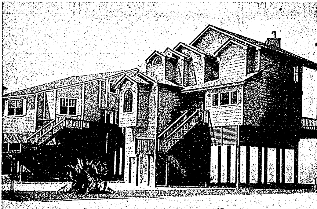
写真-11 耐水化した建物の事例
