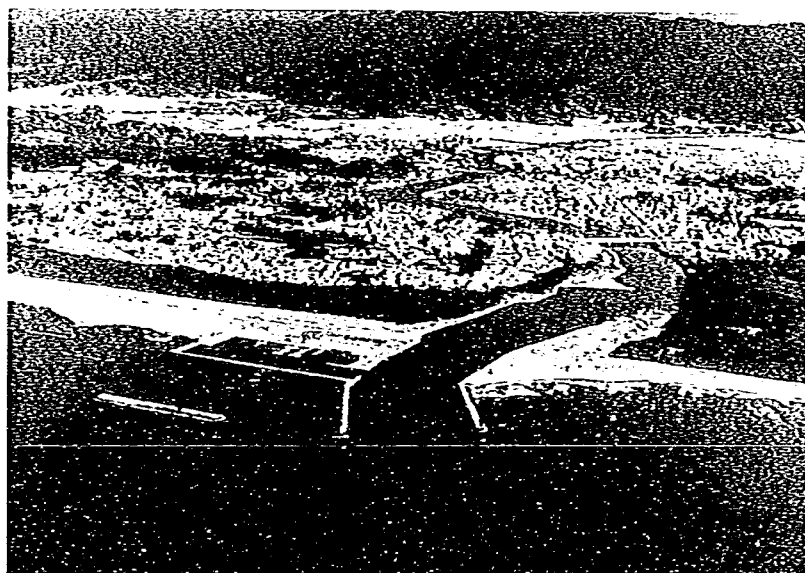
写真-3. 14 子吉川河口部の空中写真（1992年11月22日）
