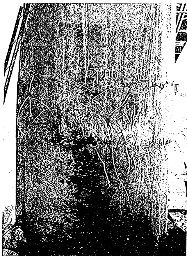
写真－2.23 P4橋脚の斜めひびわれ
