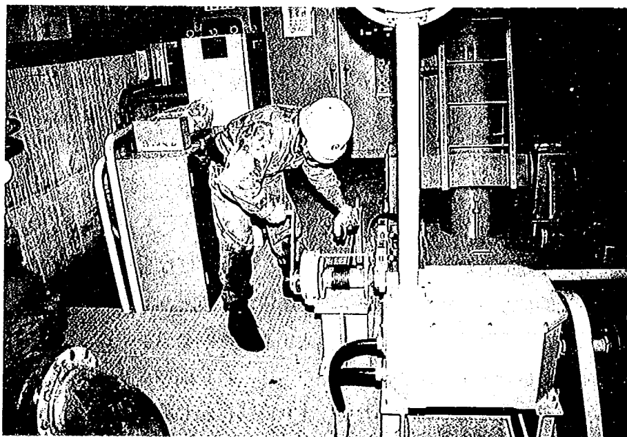
写真4.3.7.2-1 休止装置作動確認
