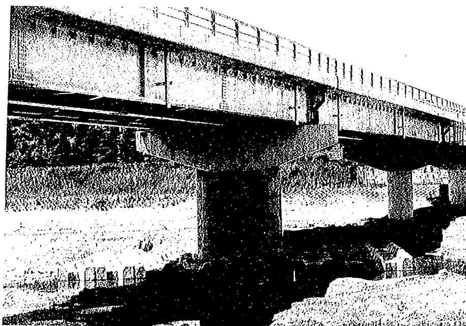
写真-1.12 補修完成
