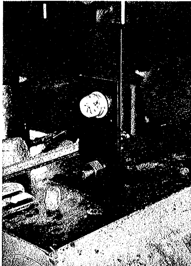
写真－ 3. 2 試験ボルトの設置状況
