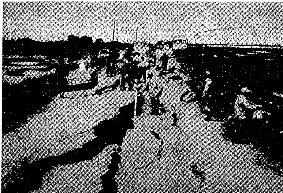
写真-1 新潟地震による信濃川堤防の被害 出典) 全国防災協会, わが国の災害誌(続), 昭和51年
