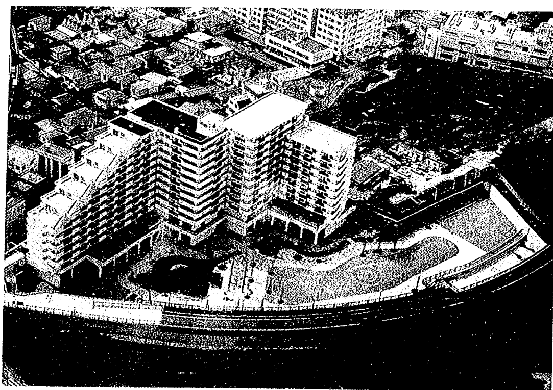
妙正寺第一調節池
