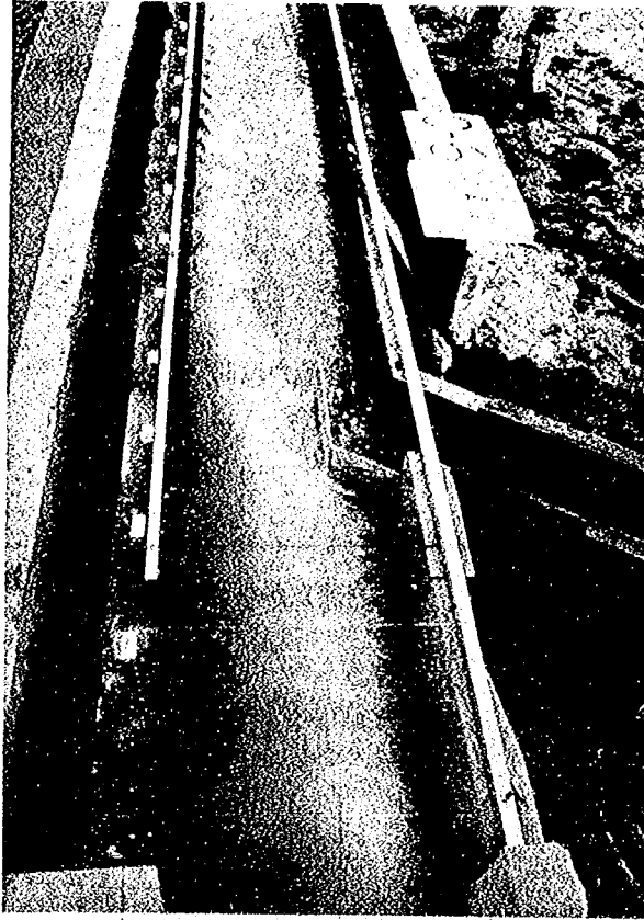
写真-15 合流点付近の流下状況 (CASE24 背割り堤あり)
