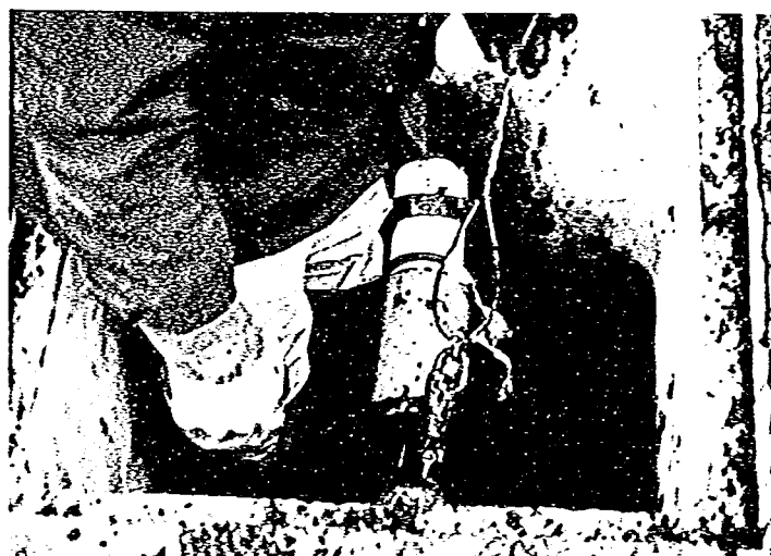
写真21 排泥用円錐コーンの装着 (小原氏の開発による)
