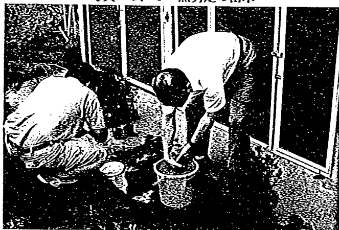
写真-3. 3 蒸散抑制処理
