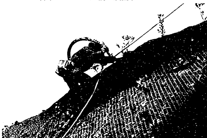
写真-4. 4 厚層基材吹付工 (右:ホースを移動させる補助者)
