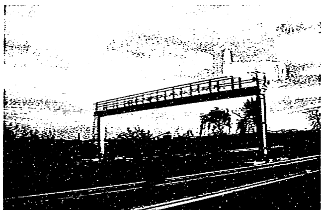
写真-3.3.7 A555に設置された実験用ガントリー
