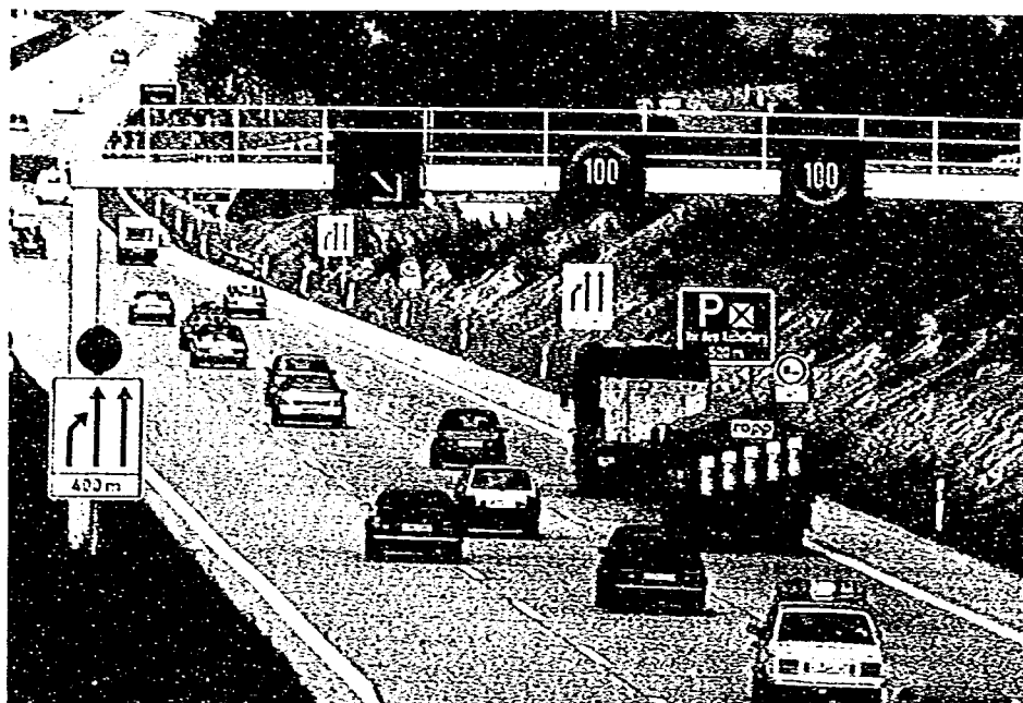
写真-3.2.2 表示装置の設置状況
