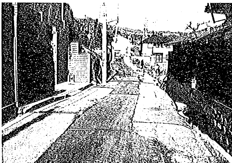
写真-2.25 斜面の滑動によって生じた道路の屈曲。この道路は地震以前は直線であった。西宮市木津山町。
