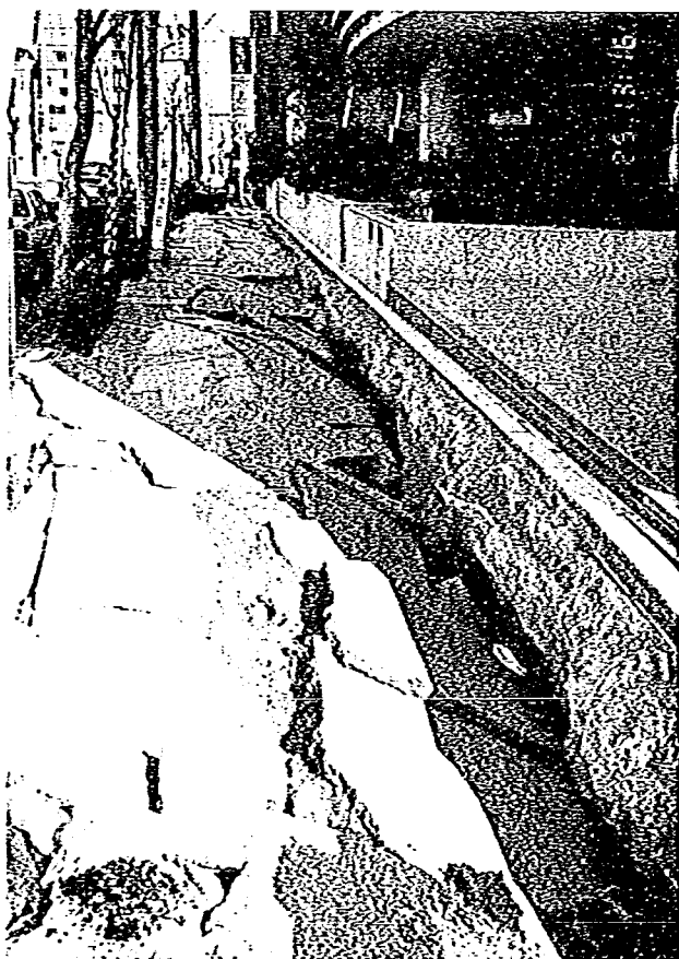
写真-3.1.2 歩道部の沈下により生じた歩道舗装破損
