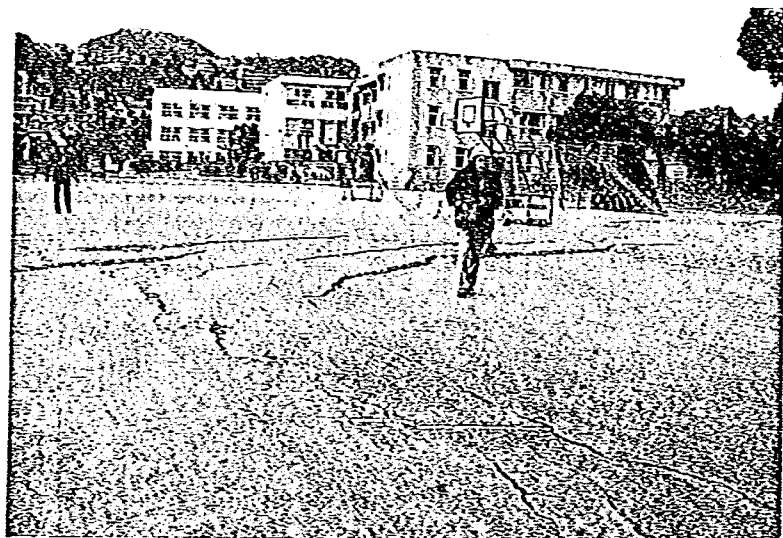
写真-2.21 大池の畔に建つ小学校の校庭に見られる亀裂。手前の人物の付近の亀裂が卓越する方向のもの。 西宮市甲陽園本庄町。
