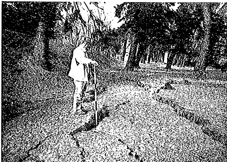
写真-3.2.6 <武庫川> 高水敷上に生じた亀裂で、深さは約90cmであった
