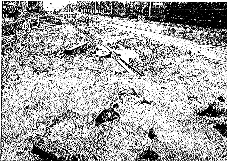
写真-2.16 噴砂によって地表に出てきたアスファルト塊・岩石塊。 ポートアイランド。
