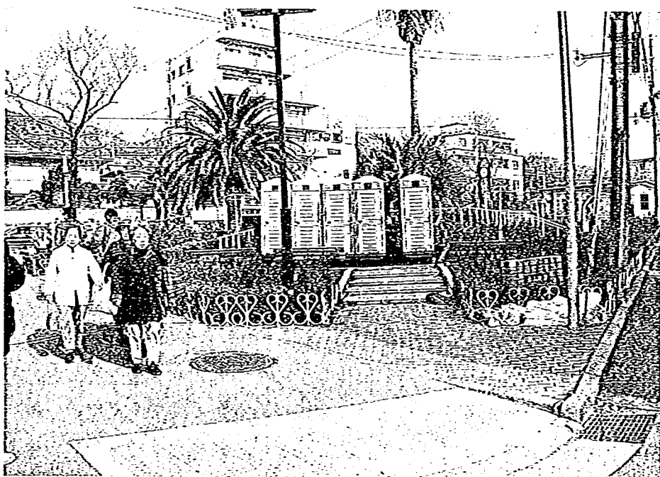
写真-3.1.14 沿道の仮設トイレ
