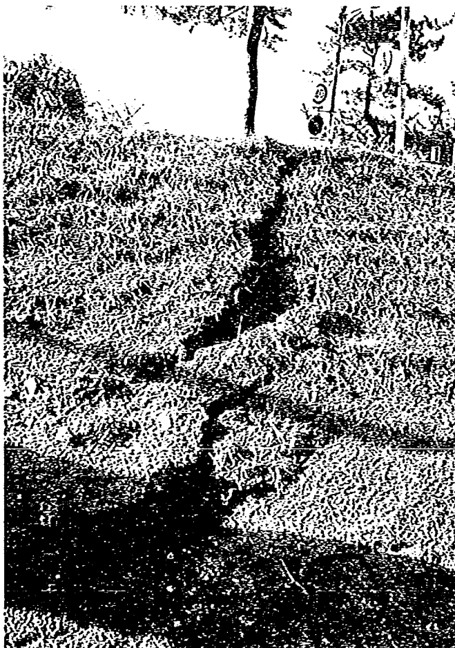
写真-3.2.7 <武庫川> 堤防ののり面に生じた横断亀裂
