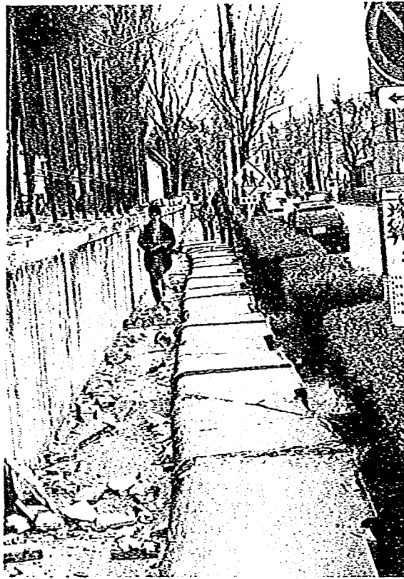
写真-3.1.11 登校路沿いの倒壊した コンクリート塀
