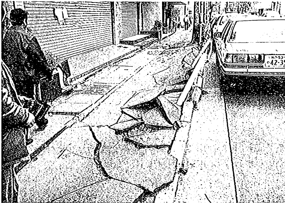
写真-3.1.6 歩道舗装と防護柵の破損
