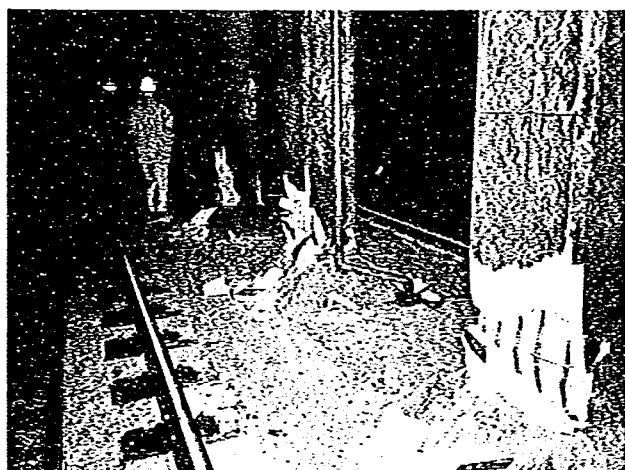
写真-3.7.3 神戸高速鉄道大開駅西側隧道部の中柱の破損
