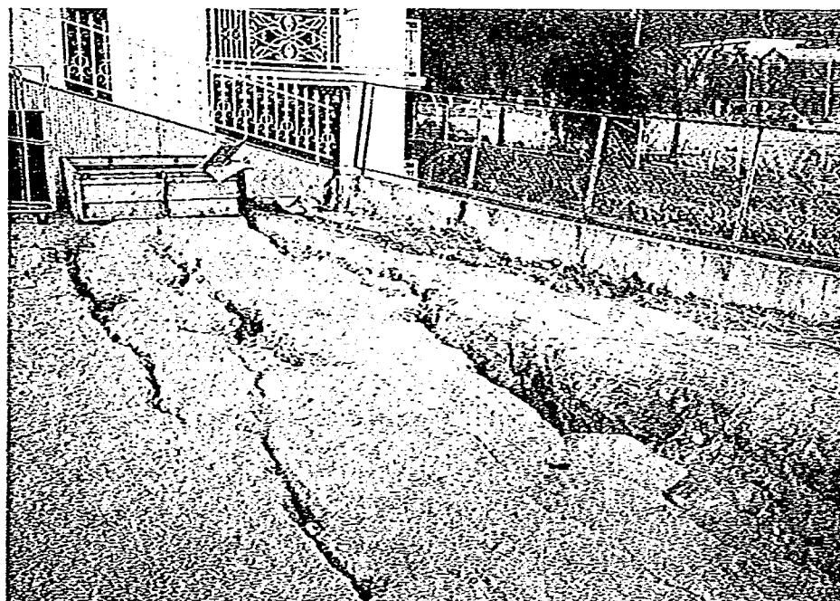
写真-2.24 池に向かう側方移動による開口亀裂。 神戸市須磨区須磨寺町。
