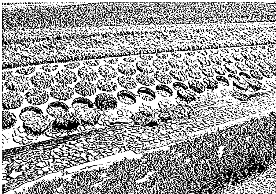
写真-3.6 間詰土の抜け出し状況（U川）
