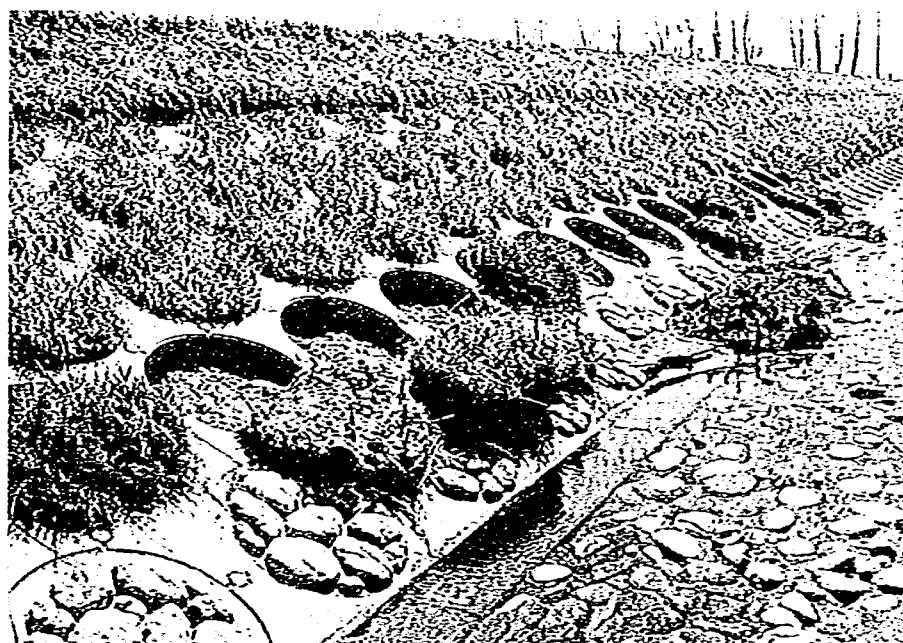
写真-3.7 被災箇所の状況（拡大）
