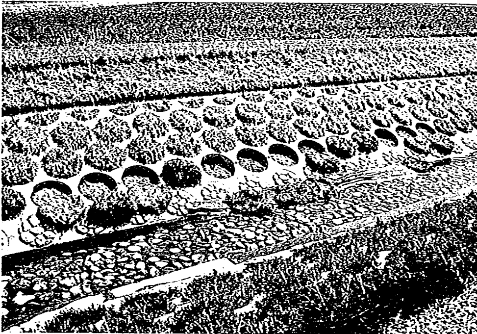
写真-3.6 間詰土の抜け出し状況（U川）
