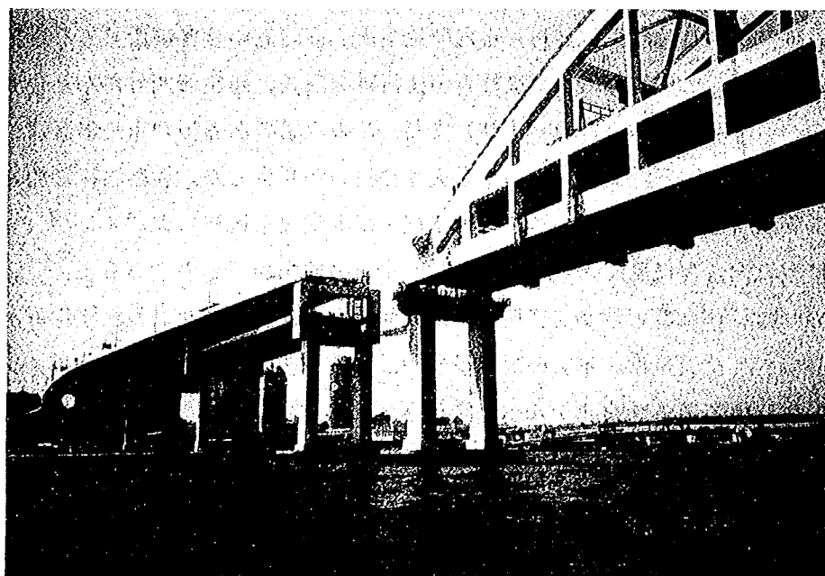
写真－１６ 船上から見た六甲アイランド橋
