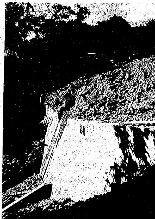
写真-19 移動土塊の流出を防いだ床固工 （清水山地すべり）
