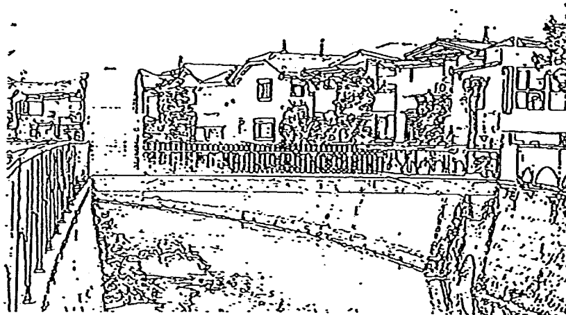
画像番号15 線画像（祖師谷中橋）
