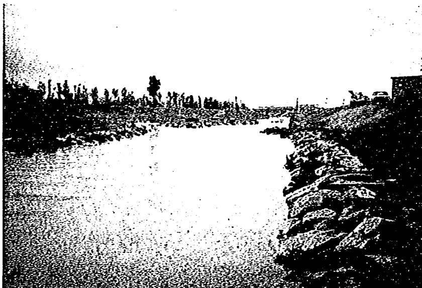
巨石を用い河岸の多孔質化を図ったが、石と石の間に有機物が堆積、嫌気化してしまった例。河岸処理ではよく取られる手法だが、こんな盲点もある。
