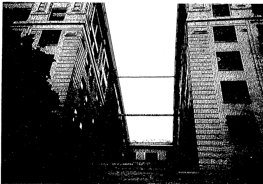
写真－ 1 5 鋼製梁による補強
