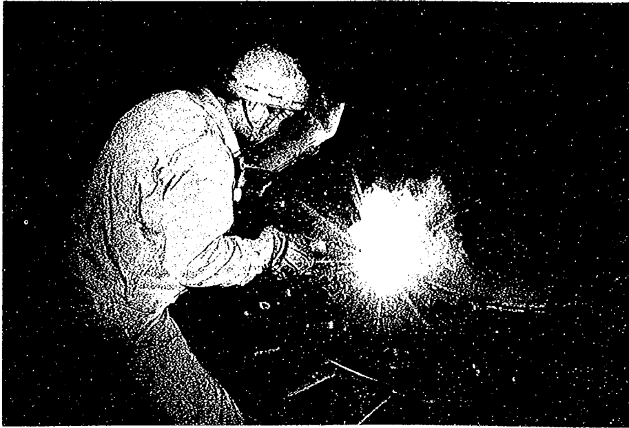
写真－２．１ 供試体製作状況（その１）
