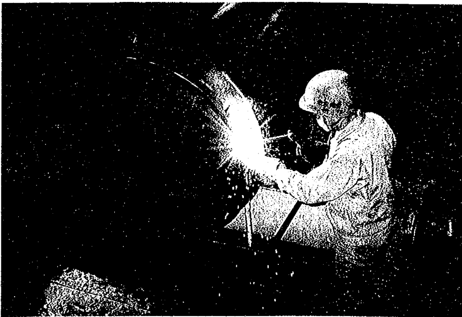
写真－２．２ 供試体製作状況（その２）
