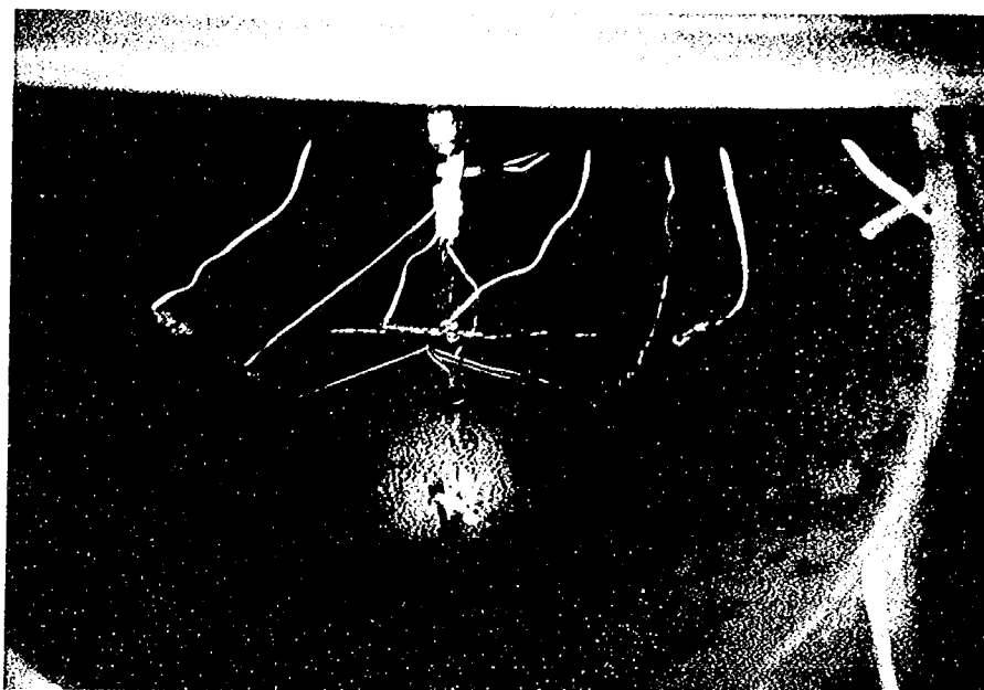
写真-2.7 コンクリート内部へのモールドゲージ配置
