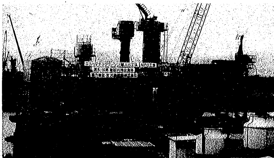
写真－4.3 天建寺橋下部工の施工状況
