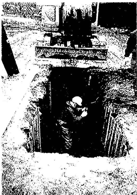
怪量鋼矢板の設置
