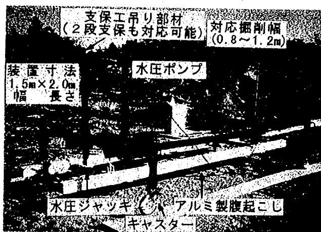
写真－4. 1. 1 可動式支保工（5S）装置
