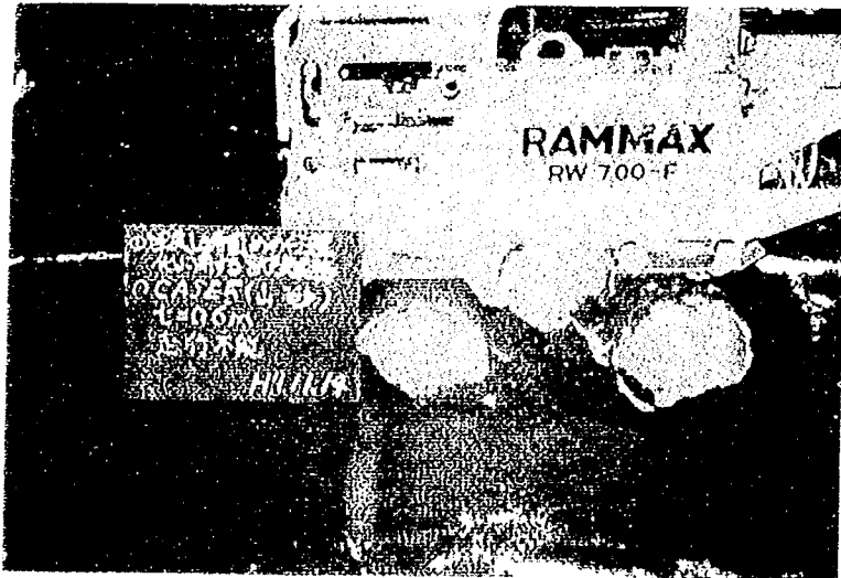
山砂の場合、まき出し厚を大きくすると初期沈下が大きく、機械が土に埋もれ車輪が空回転してしまう。
