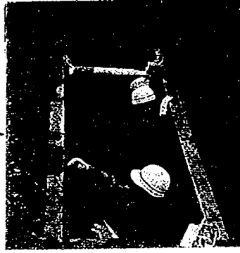
②支保工の設置
