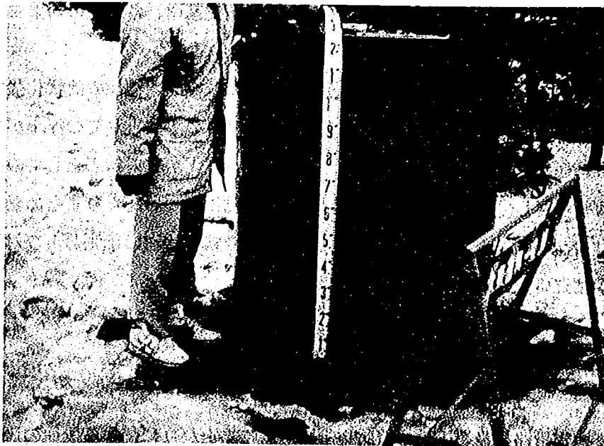
写真1.1 釧路沖地震で浮き上がったマンホール
