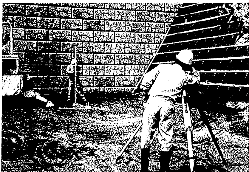
写真-3 変位杭測定
