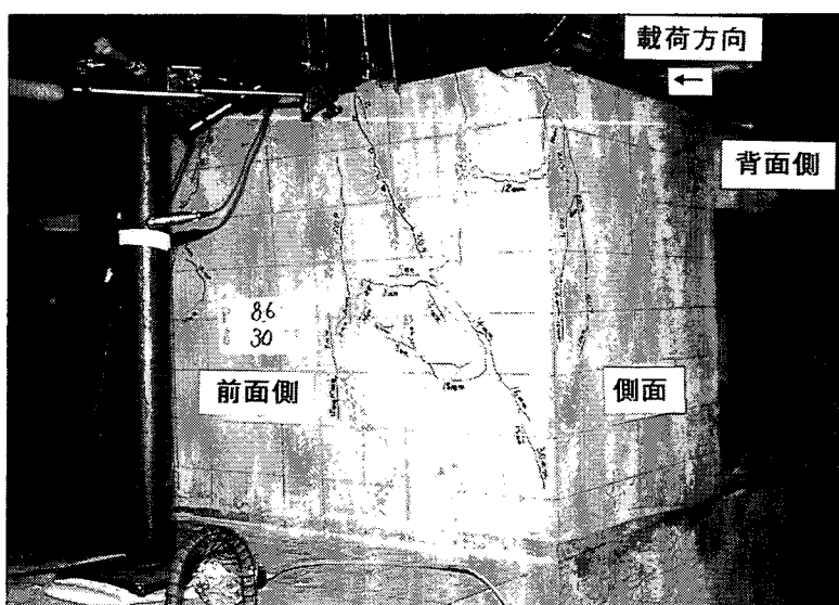
最終変位時ひび割れ状況 (BP-S-B試験体)
