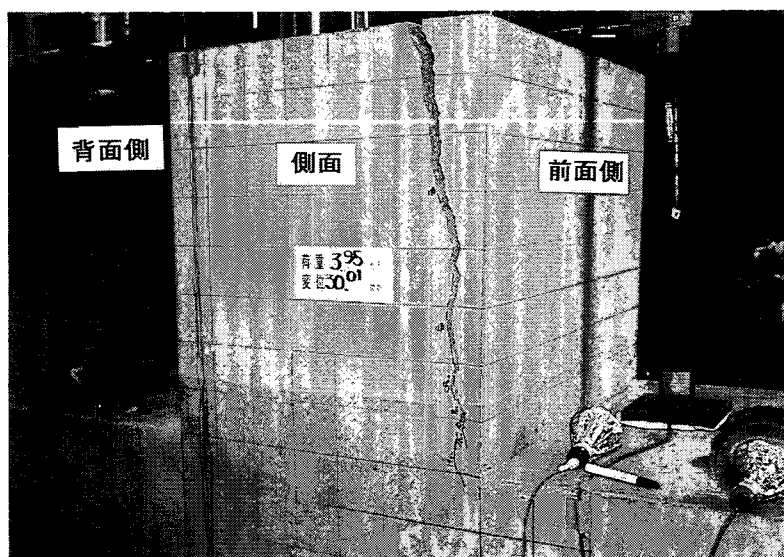
最終変位時ひび割れ状況 (AB-L試験体)
