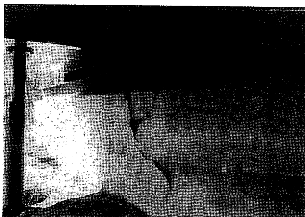
写真-3.4.5 固定支承を支持する橋台躯体の破壊（りんどう大橋）
