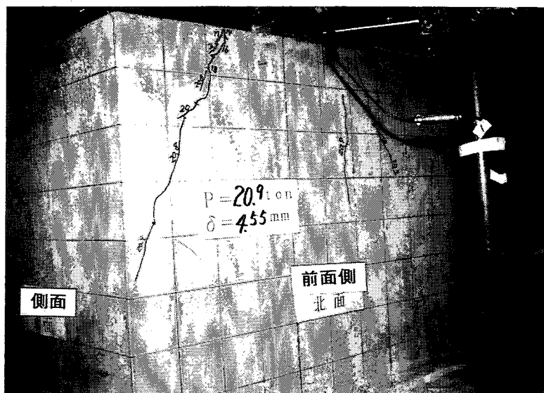
最大荷重時ひび割れ状況 (BP-S-B試験体)
