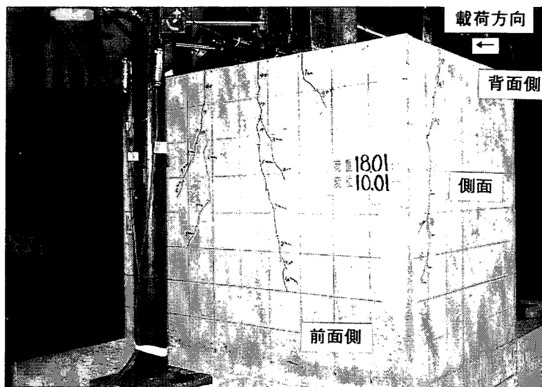
最大荷重時ひび割れ状況 (BP-L-D試験体)
