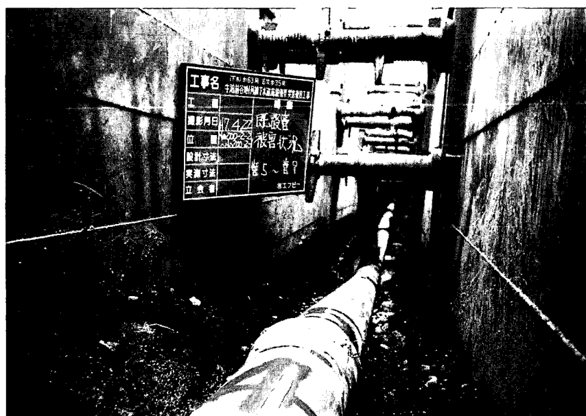
写真7.2 区間7で生じた塩ビ管の不同変位（十和田市提供）
