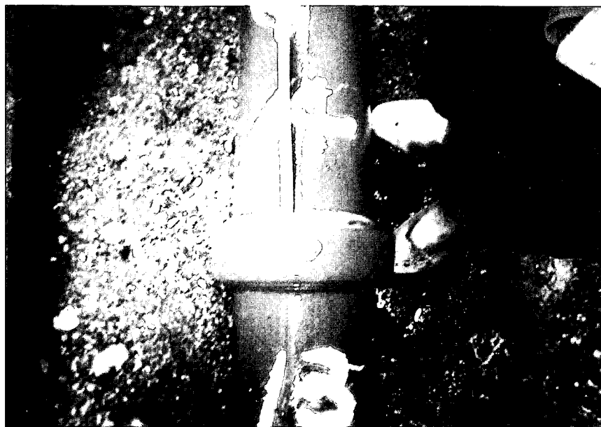
写真7.3 区間6で生じた陶管の継手部の開き（十和田市提供）
