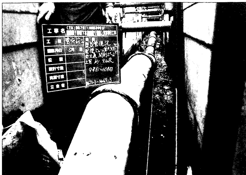
写真7.1 区間11で生じたヒューム管の不同変位（十和田市提供）
