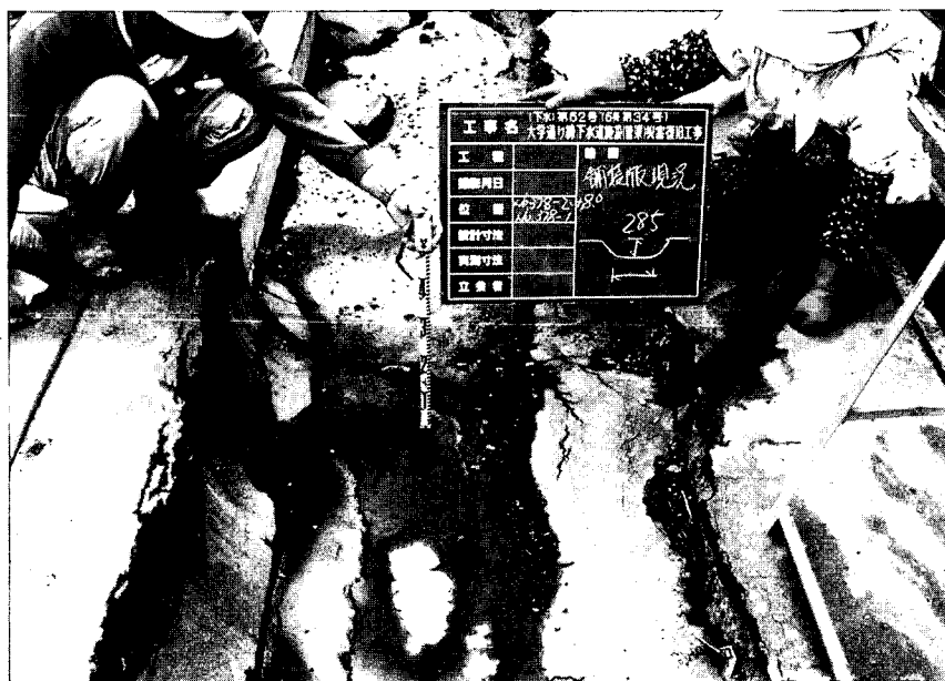
写真7.4 区間 6 で生じた埋戻し部の沈下 (十和田市提供)
