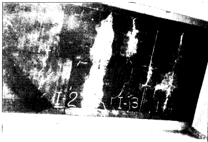
写真-3.4 コンクリート床版の遊離石灰
