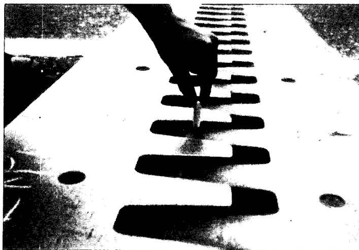
写真-3.8 伸縮装置の段差
