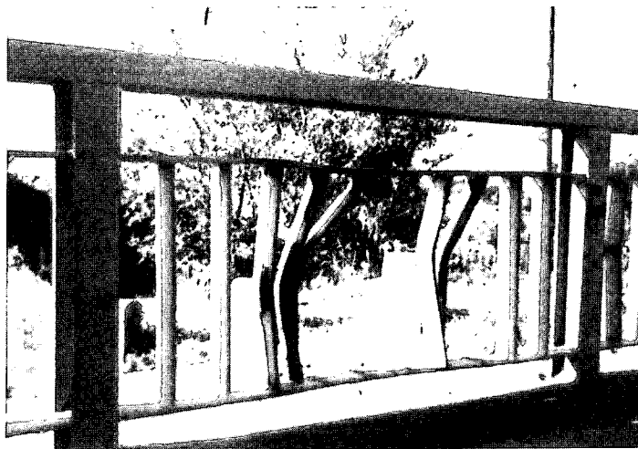
写真－3.13 高欄の変形
