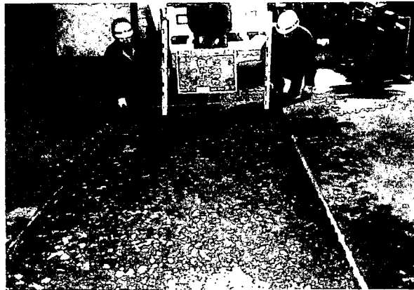
現場の施工方法
