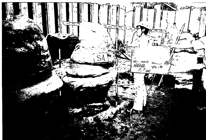
S 4 (ステップ長=33 cm):改良径 \phi 1.1 m 写真-3 固結状況 (S 2, 3, 4: 一点注入)
