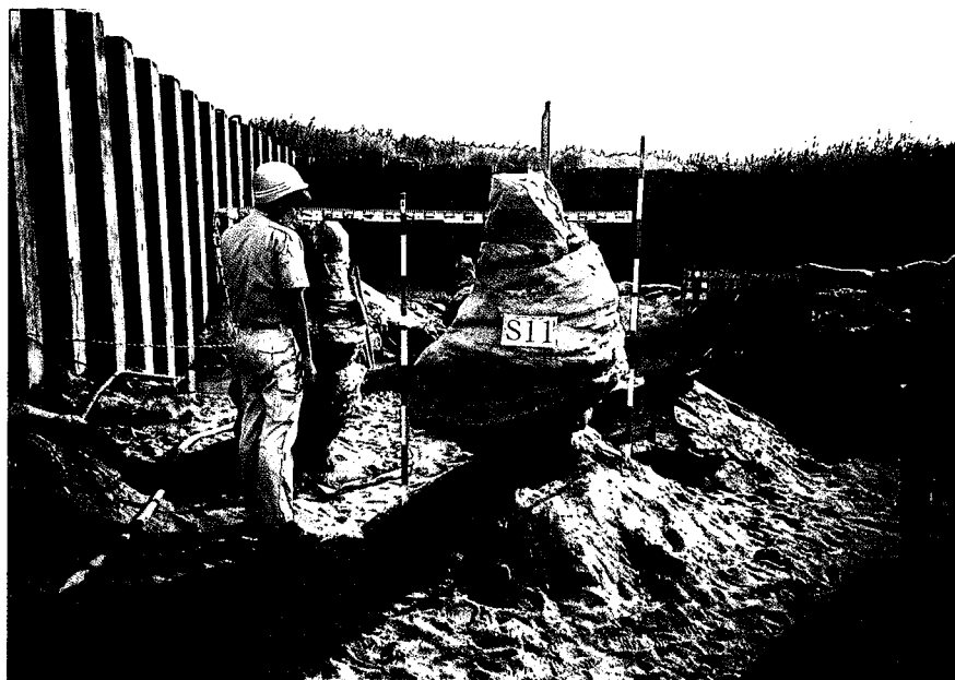
上部固結体：改良径 \phi 1.2\text{ m} (YP + 3.72 m 以浅)
