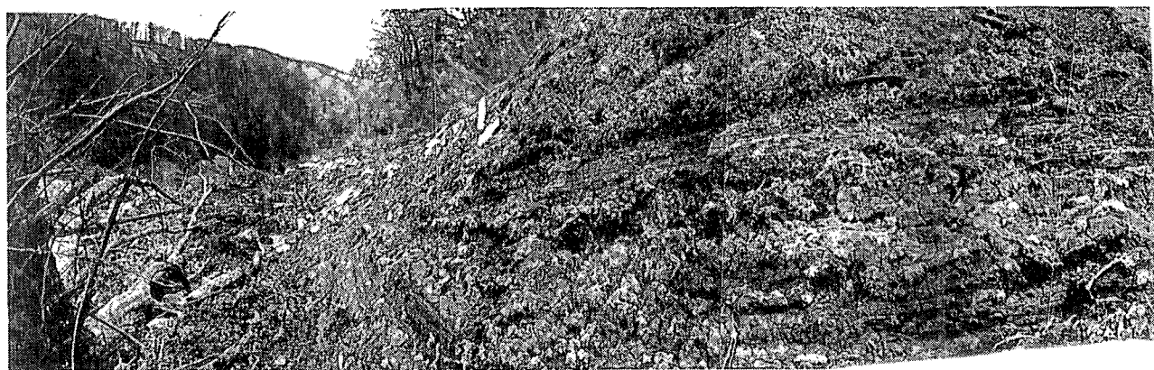
写真-3.6.1 赤川上流右岸に見られる土石流の擦痕
