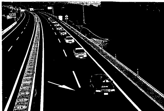
写真-2 上信越自動車道自動運転実験
