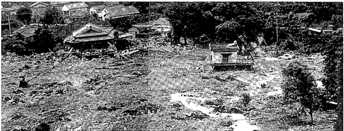
写真-4.4.1 土石流の氾濫堆積状況
