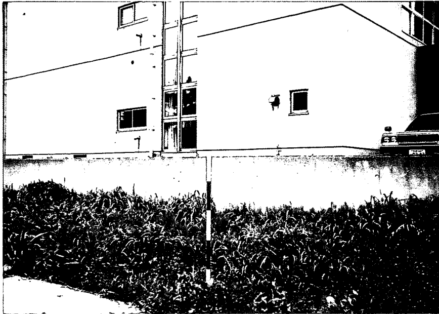
写真－6 カルチャーセンターの盛土状況
