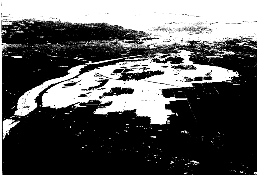
写真－５ 氾濫水の伝播状況（島田橋付近から上流側を見る） 月岡地区における破堤に伴う氾濫水は1.3km／時で伝播し、破堤地点から約3km下流の島田橋まで到達した
