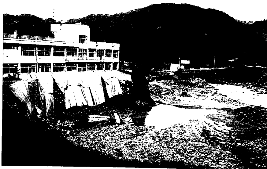
写真－３ 新井南中学校のプール流失
