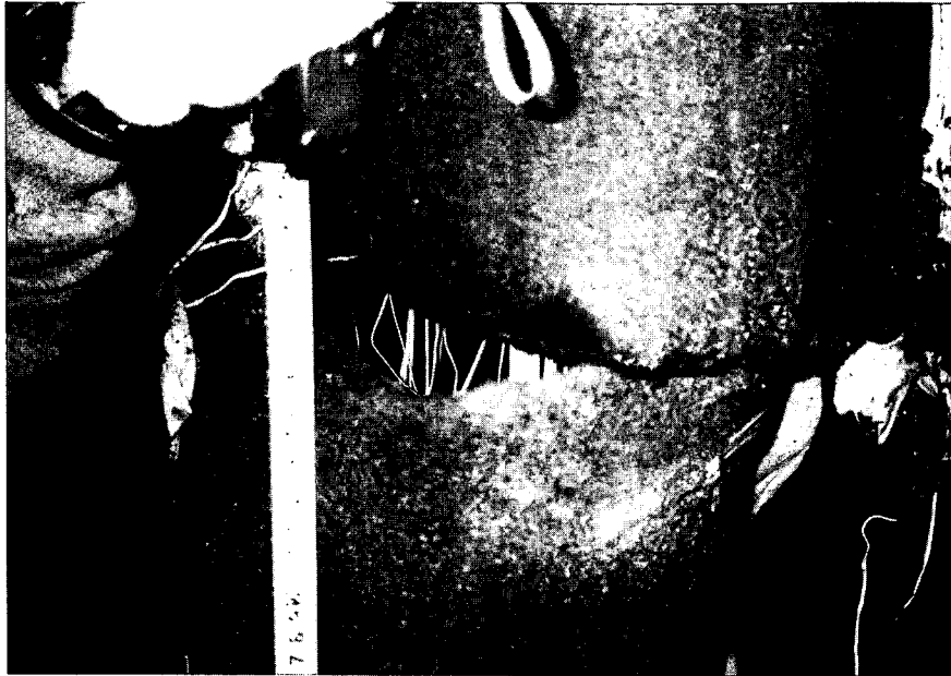
写真-4-1 鋼管杭（ケース 2）の損傷状況
