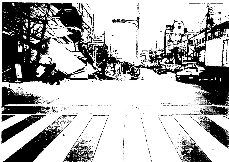
写真-1. 3. 8 家屋倒壊 (国道2号)
