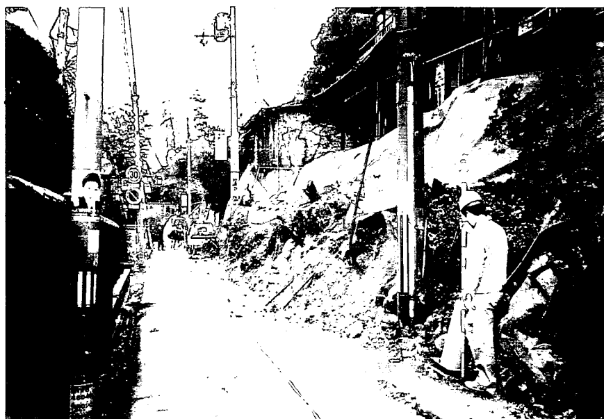
写真-1. 3. 10 擁壁 宝塚市湯本町
