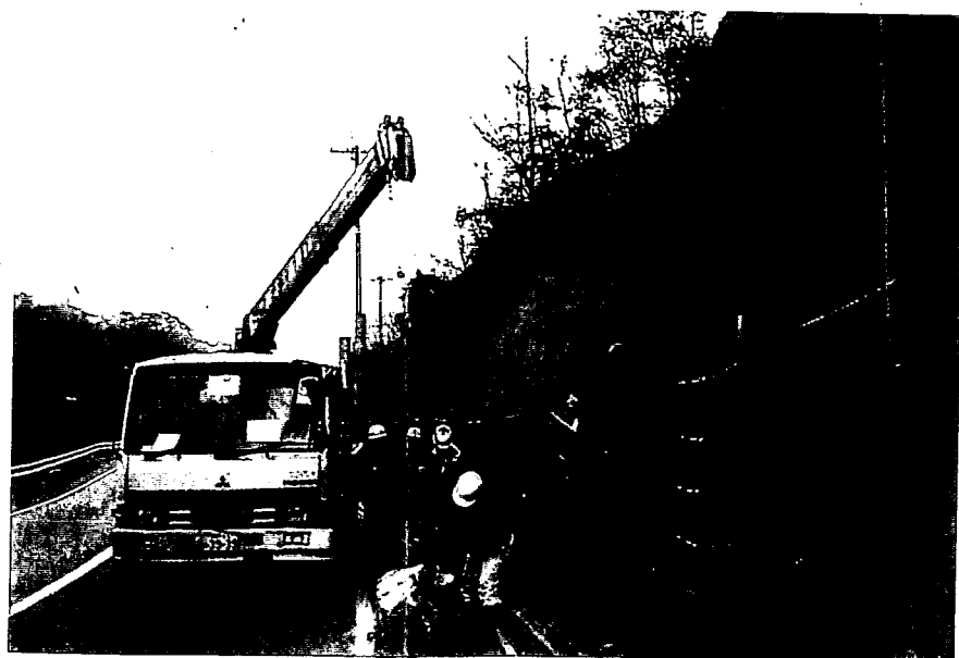
写真-1. 3. 13 落石 西宮市越水
