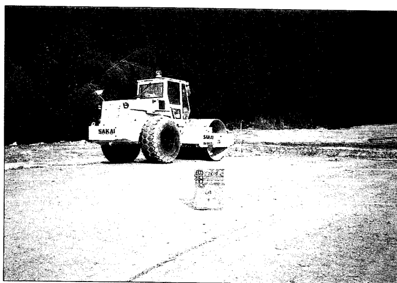
写真－３ 基層転圧状況
