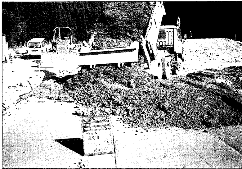
写真－４ 試験層まき出し状況
