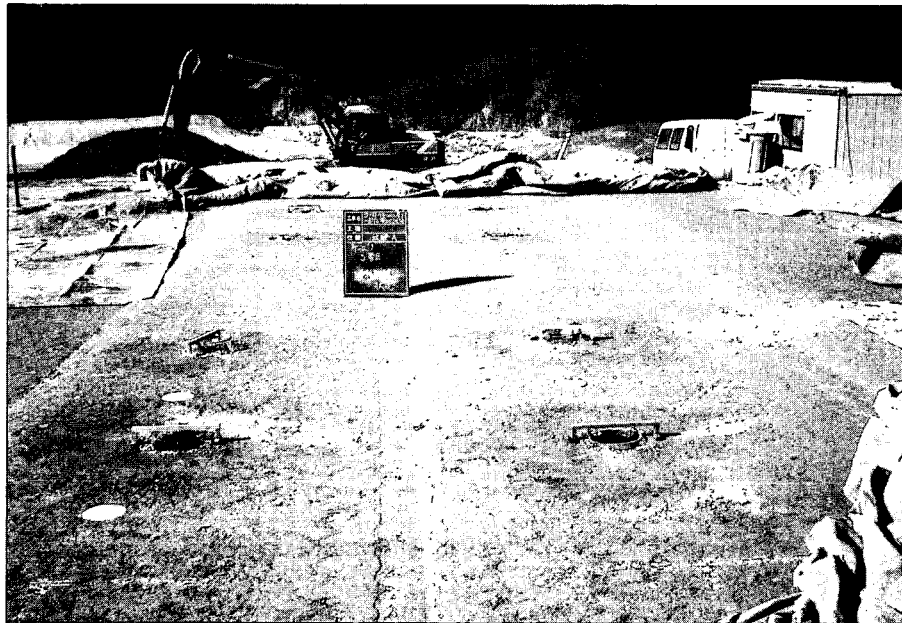
写真－13 透水試験全景
