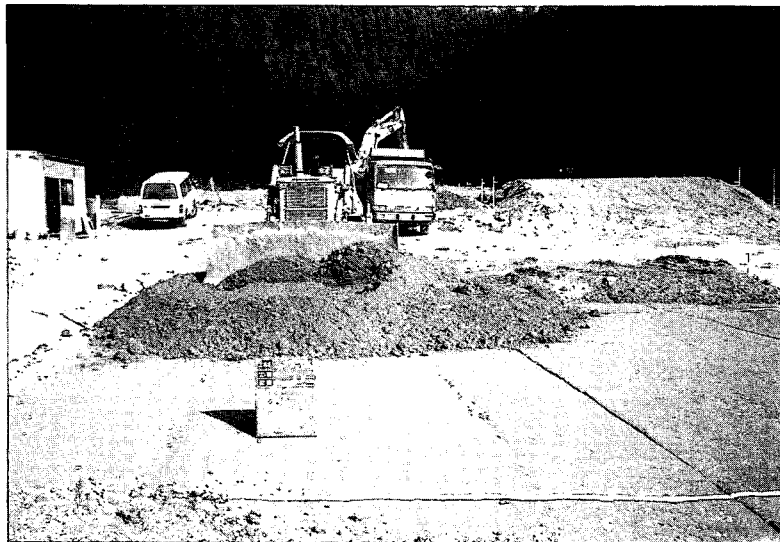
写真－５ 試験層敷均し状況
