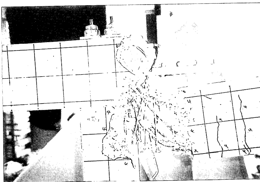
写真-4-6-4 b 1-4 供試体主梁載荷点西面 (3.0m, 2回目)
