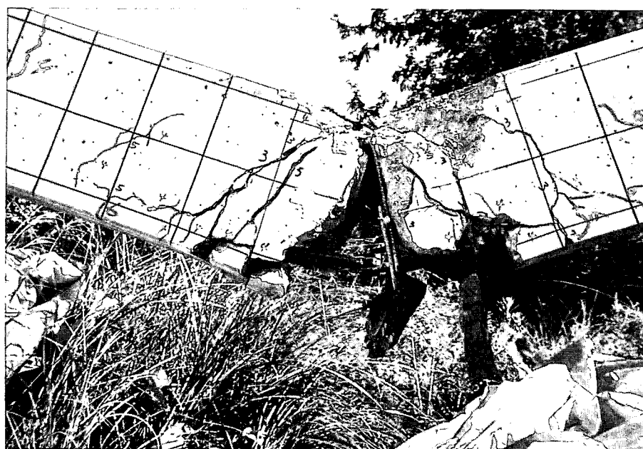
写真－4－6－1 b 1－1 供試体主梁載荷点西面 (2.0m, 2回目)
