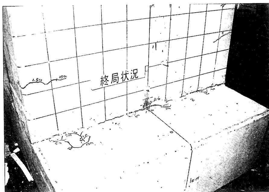
写真-3・5・4 f S-4 供試体擁壁西面下側（終局状態）
