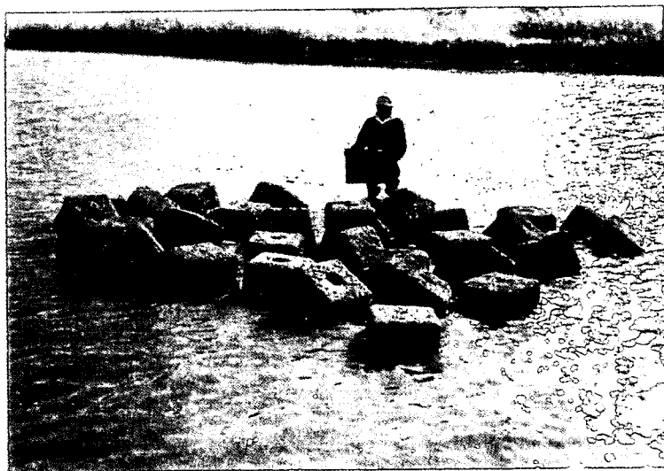
写真 魚巢ブロック設置状況
