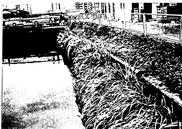
写真7. 5 植栽フィン設置1年3ヶ月目の状況
