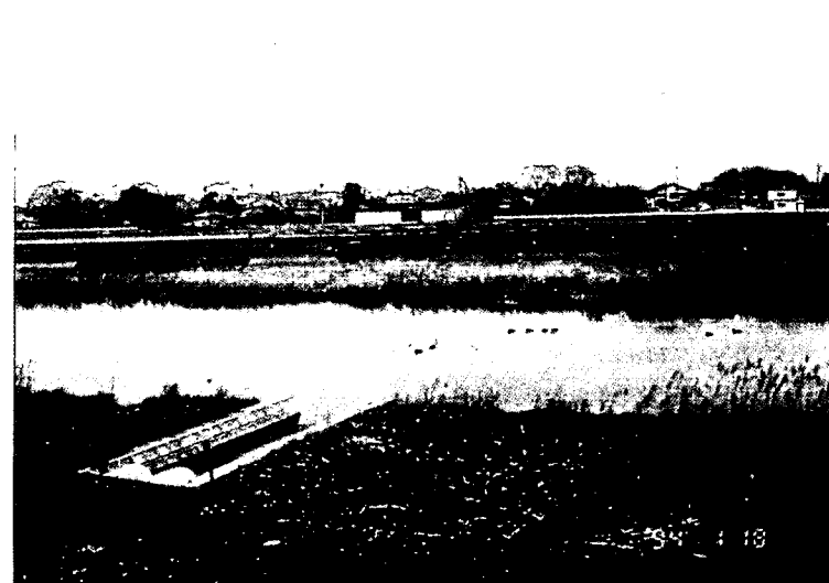
写真 団地側からの雨水流入口
