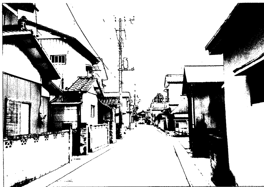
写真－4. 1 覆蓋側溝の状況（水海道市 調査地点K－3）
