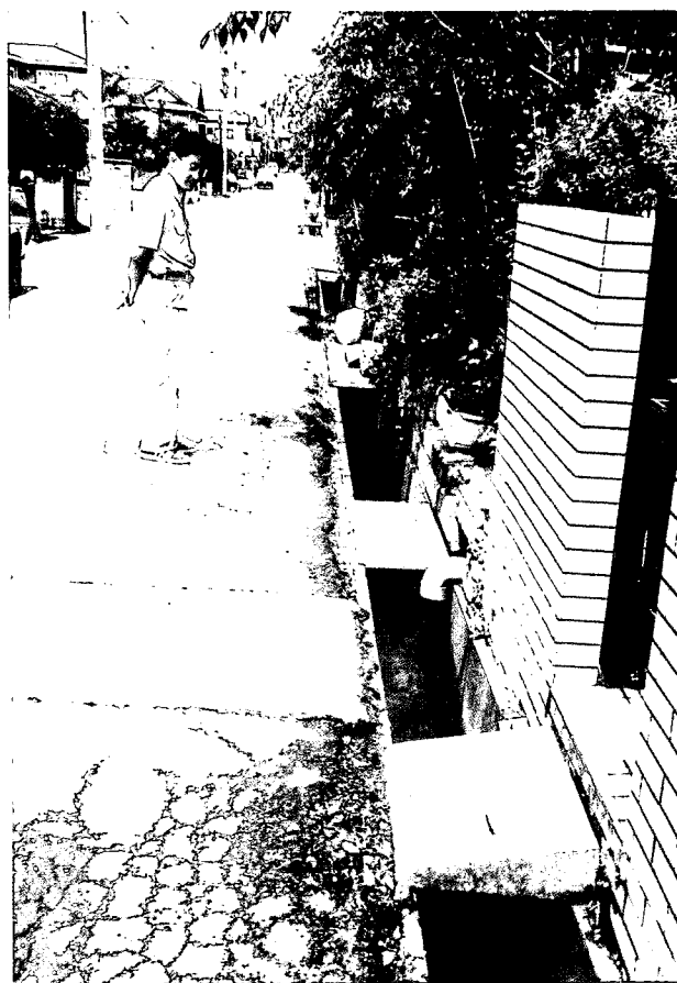
写真－参 1. 1 開渠側溝の多い下水道未整備地区（調査地点 A）
