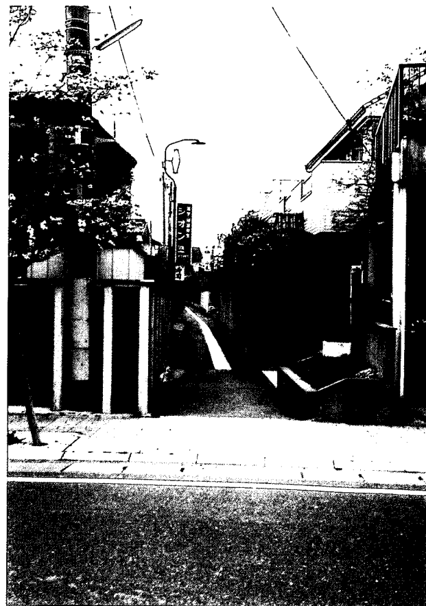
写真－参1. 8 覆蓋化された排水路（調査地点K－6）
