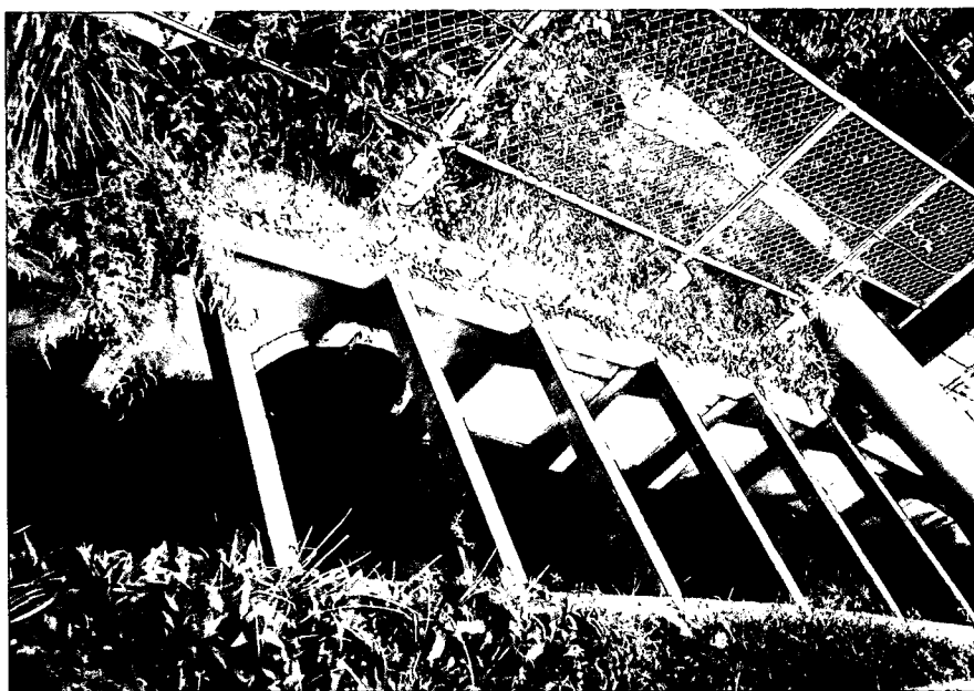
写真－参1．6 住宅団地の排水路の末端部（調査地点 B-3）
