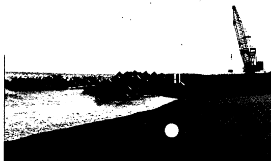
写真-3.11 測点No.14に施工中の大型突堤 北側の海岸状況 (1995年2月2日撮影)
